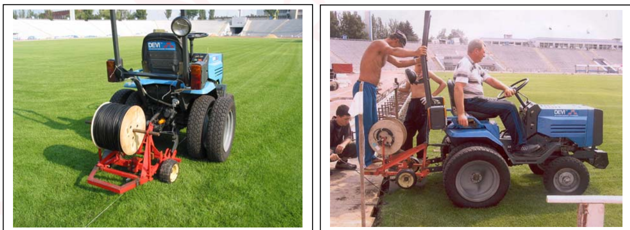
Рис. 2 - 3. Монтаж нагревательного кабеля deviflex™ DSM3 на футбольном поле с помощью специального плуга.
