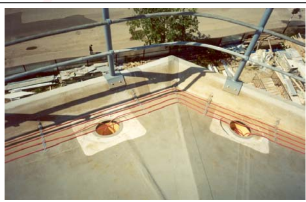
Рис. 5. Монтаж нагревательного кабеля deviflex™ DTIP-18 на крыше.
