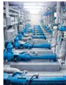
Насосы seerex BN 52-6L. Продукт: сгнивший шлам в обезвоживающих центрифугах.
