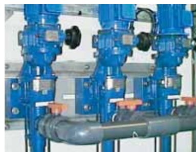
Насосы seerex BN 05-12 . Продукт: Дозировка сульфата железа для осаждения фосфата.
