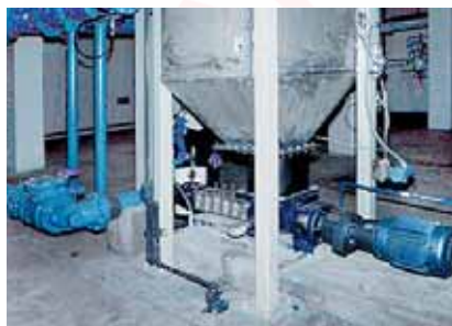
Насосы seepex BTQ 17-12. Продукт: механически сгущенный избыточный шлам примерно с 6% сухого остатка.
