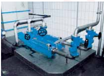
Насосы seerex BN 17-12 и BN 5-24. Продукт: сгущенный шлам в камерный фильтр-пресс.
