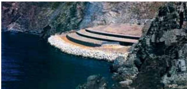
Подземная очистная установка на берегу Средиземного моря, в скале.
