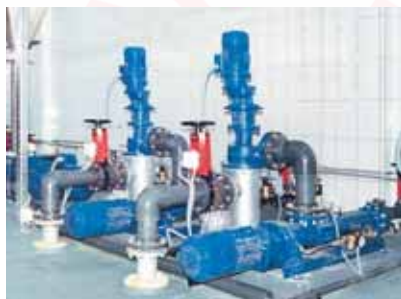
Насосы seerex BN 30-6LT с измельчителями seerex U 25 . Продукт: сгнивший шлам к ленточным сетчатым прессам.
