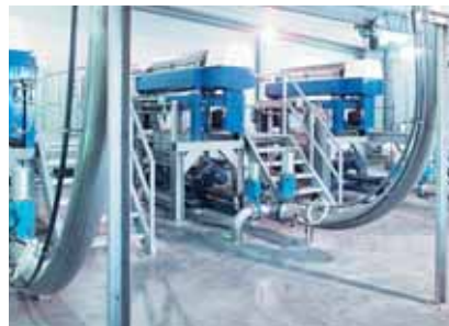
Насосы seerex BT1 10-24 . Продукт: обезвоженный шлам из центрифуги с примерно 20% сухого остатка.
