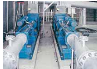
Насосы сеерех ТИНС 70-24. Продукт: обезвоженный шлам из центрифуги. Особенность: Обработанный известью в насосе шлам содержит примерно до 40% сухого остатка и транспортируется в бункер для шлама.
