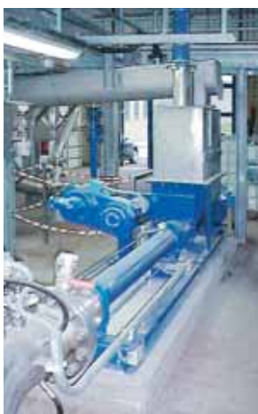
Насос сеерех ВТ1 35-24. Продукт: обезвоженный шлам с 20% сухого остатка из центрифуги. Особенность: В съемную воронку насоса добавляется известь. Шлам с 35% сухого остатка транспортируется к месту хранения шлама. Напорный трубопровод выполнен с местами впрыска смазки с целью окращения потерь давления.
