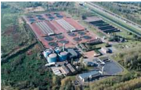
Воздухозаборник очистной установки.
