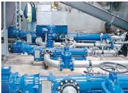
Насосы seerex BT 70-12 и BN 52-6L . Продукт: импортрованный обезвоженный шлам с 30% сухого остатка и первичный шлам примерно с 1 - 2% сухого остатка. Особенность: обратное перемешивание импортрованного шлама с первичным шламом примерно до 6% сухого остатка и дальнейшая транспортировка к септической камере. Первичный шлам подается сбоку в загрузочную воронку.
