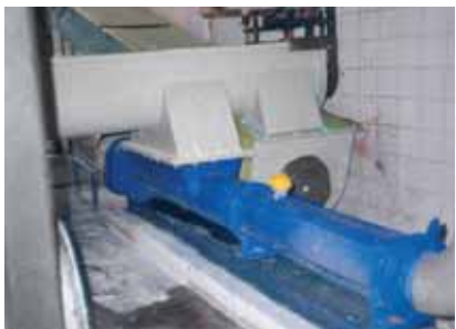
Насос seepex BT 70-6L, продукт: рыбный концентрат для транспортировки в сепаратор, температура: 90°C давление: 2 бар, производительность: 12-22 м 3 /ч
