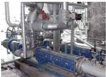
Насос seepex BN 130-12, продукт: выжимка в винокурении, 10% TR, вязкость: 2000 сП, температура: 65°C давление: 8-12 бар, производительность: 40 м 3 /ч
