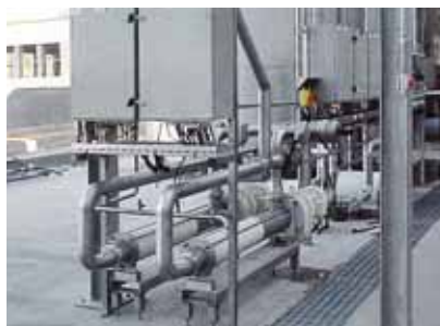
Насос seepex BCSB 52-6L, продукт: джем с цельными фруктами, давление: 4 бар, производительность: 10-20 м 3 /ч
