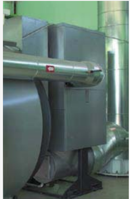
Водогрейный котел серии Vitomax 200, оснащенный экономайзером Vitotrans 333
