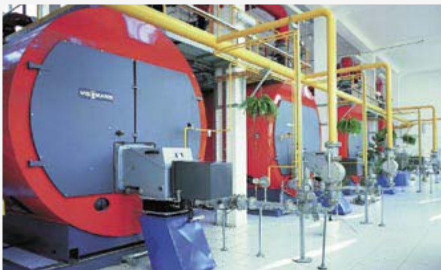
Turbomat-RN-HW – водогрейная котельная 6 x 10 МВт
